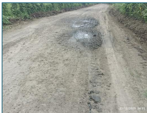
Vías con capa de rodadura Tierra
