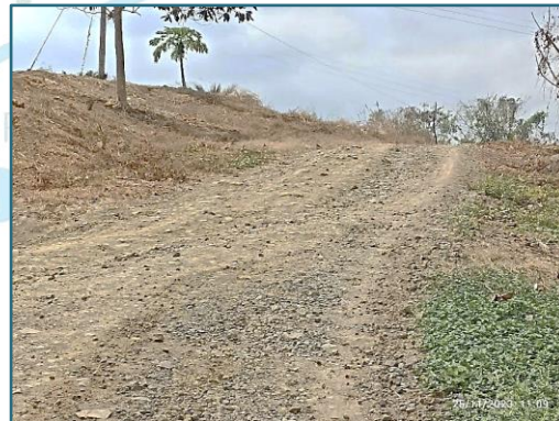
Vías con capa de rodadura Lastre
