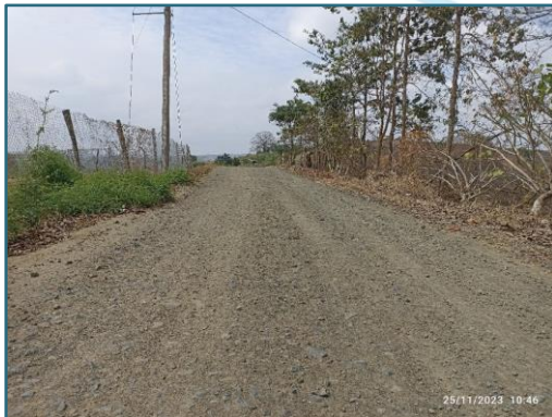
Vías con capa de rodadura Lastre
